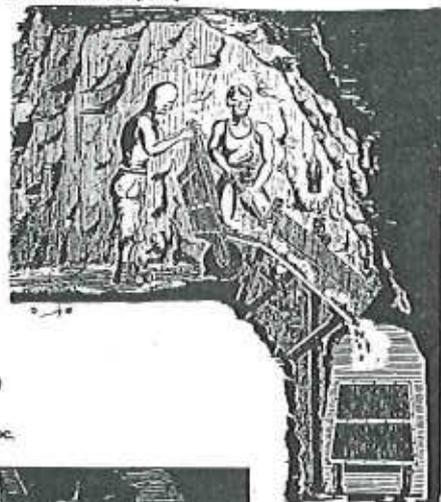
Sgombro della galleria mediante "carretta a mano ad una ruota" (1) operata dallo "spazzino" (2).
